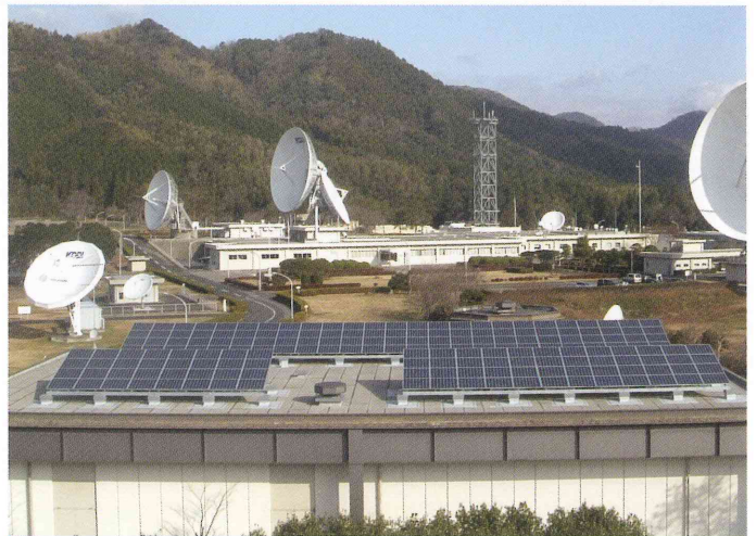
KDDI株式会社 山口衛星通信センター パラボラ館様 30kW
