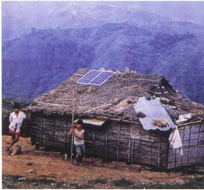
住宅用ライティングシステム 102W (フィリピン)
